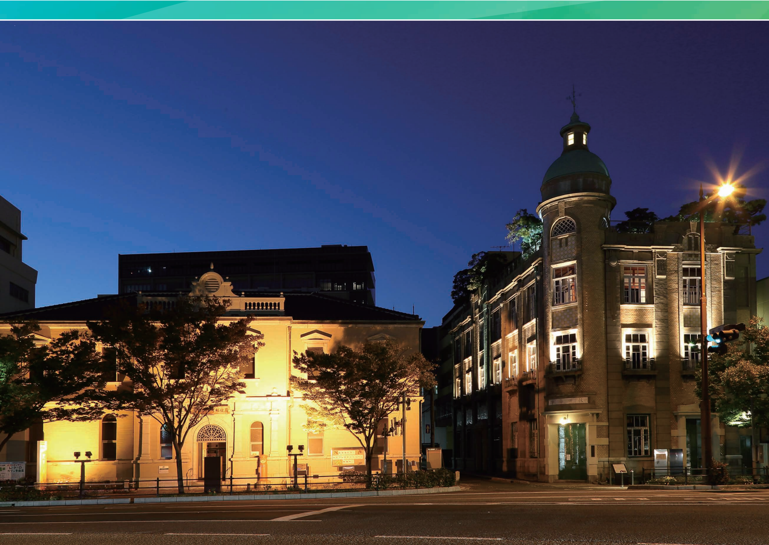
山口県下関市 南部町郵便局庁舎／旧秋田商会ビル
