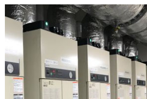
ボイラープラント
