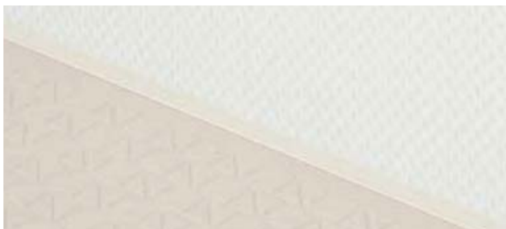
床目地(樹脂目地)
