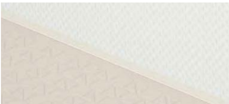
床目地(樹脂目地)
