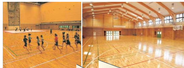
■ ジョイントレスゴムチップパネルによる温水床暖房
